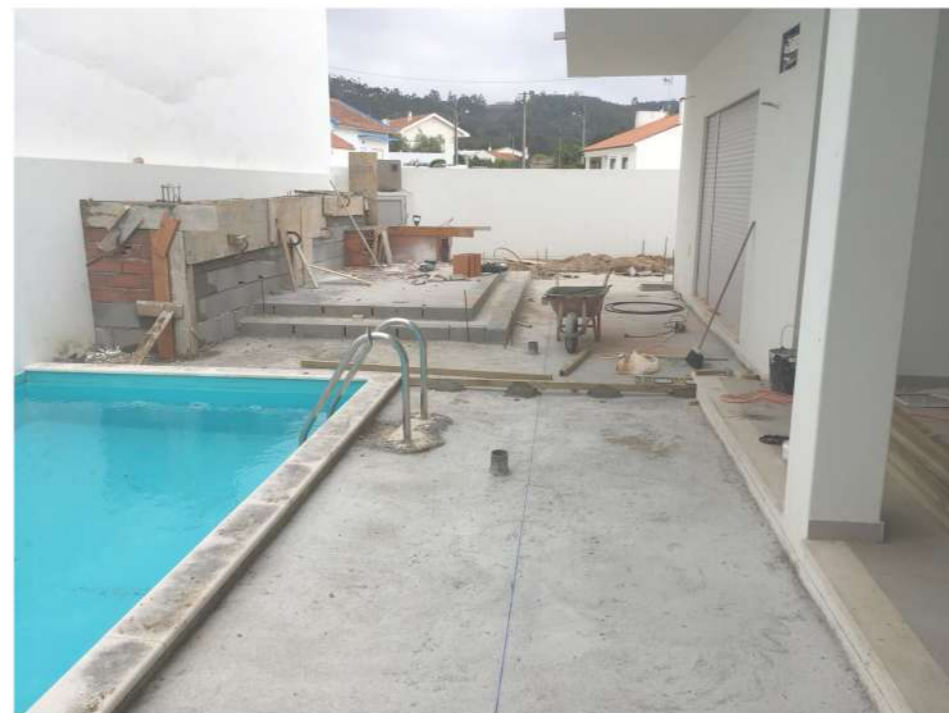
DURANTE a obra
