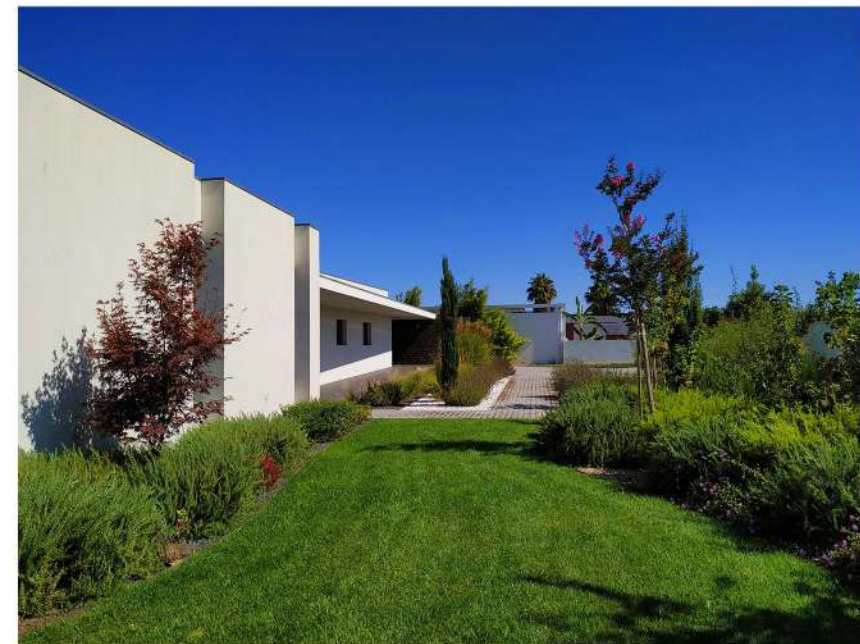
DEPOIS da intervenção.
