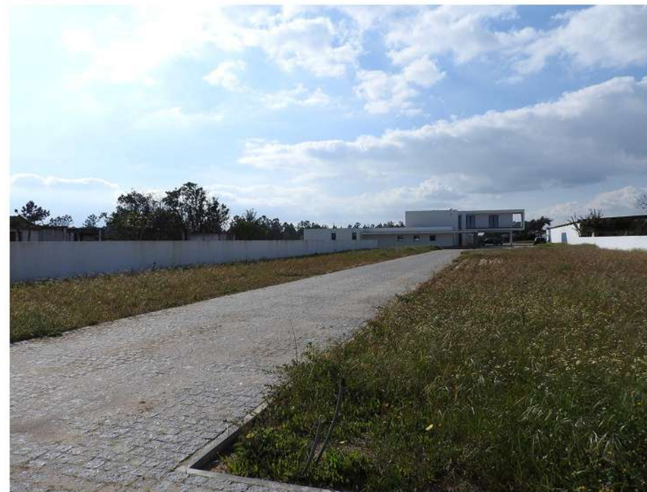
ANTES da intervenção.
