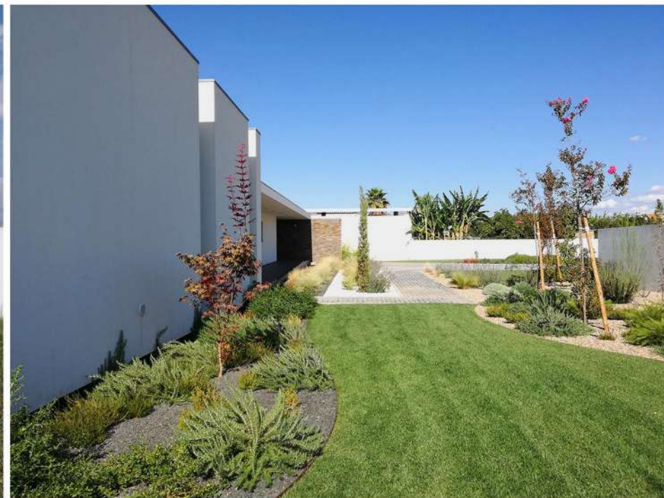
DEPOIS da intervenção.
