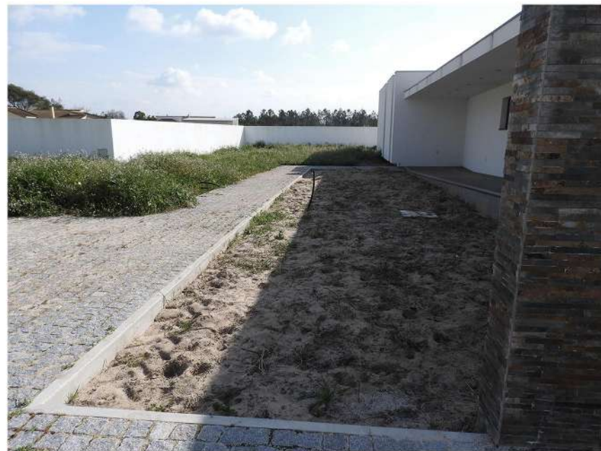
ANTES da intervenção.
