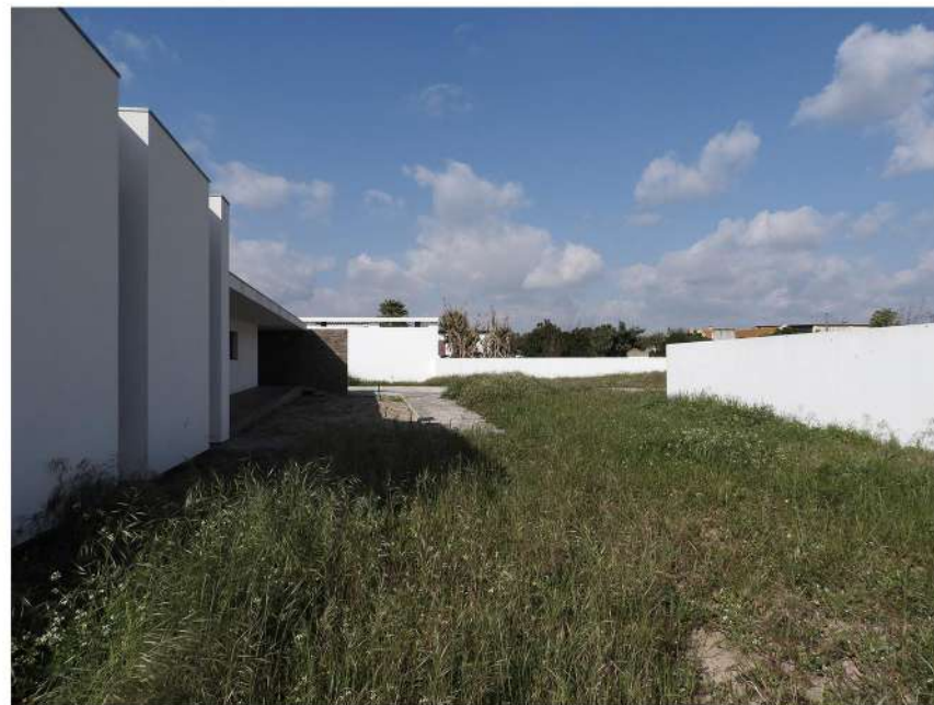
ANTES da intervenção.
