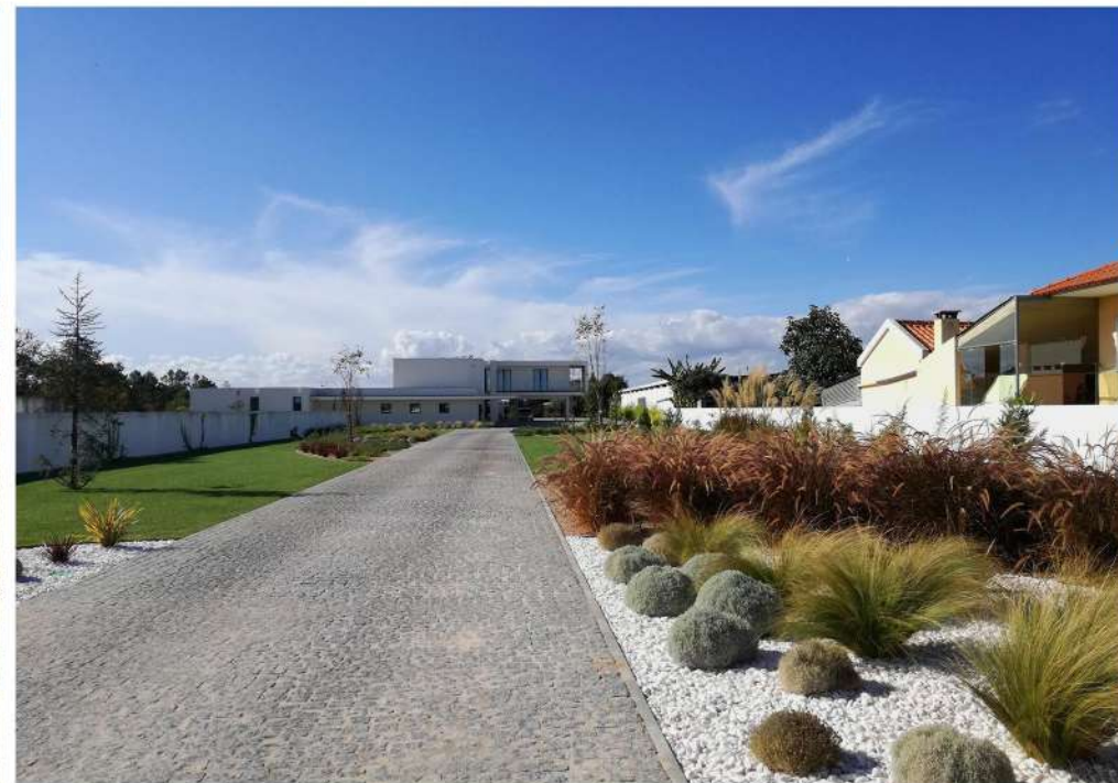
DEPOIS da intervenção.
