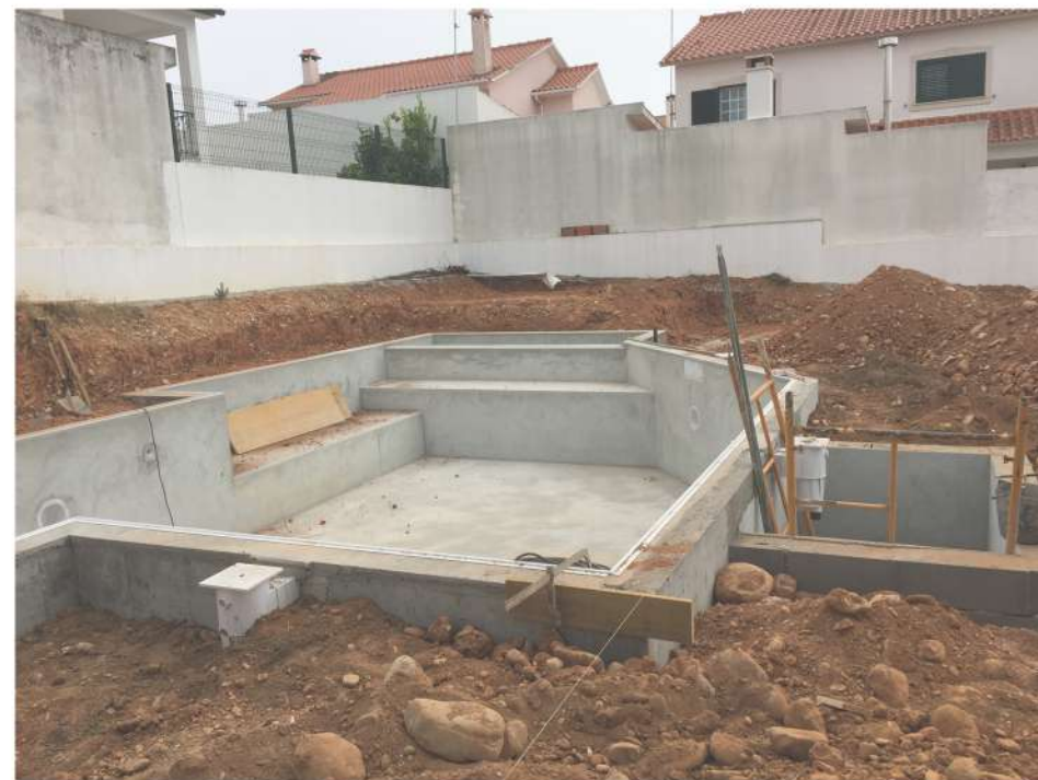
DURANTE a obra
