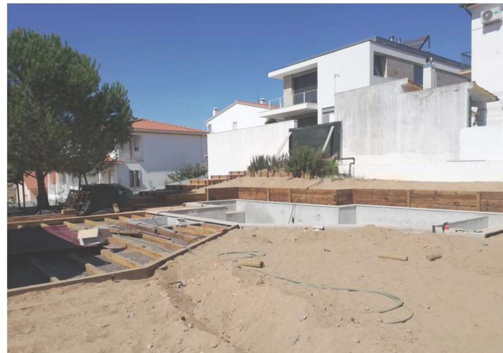
DURANTE a obra
