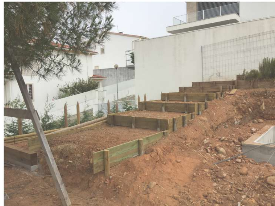
DURANTE a obra
