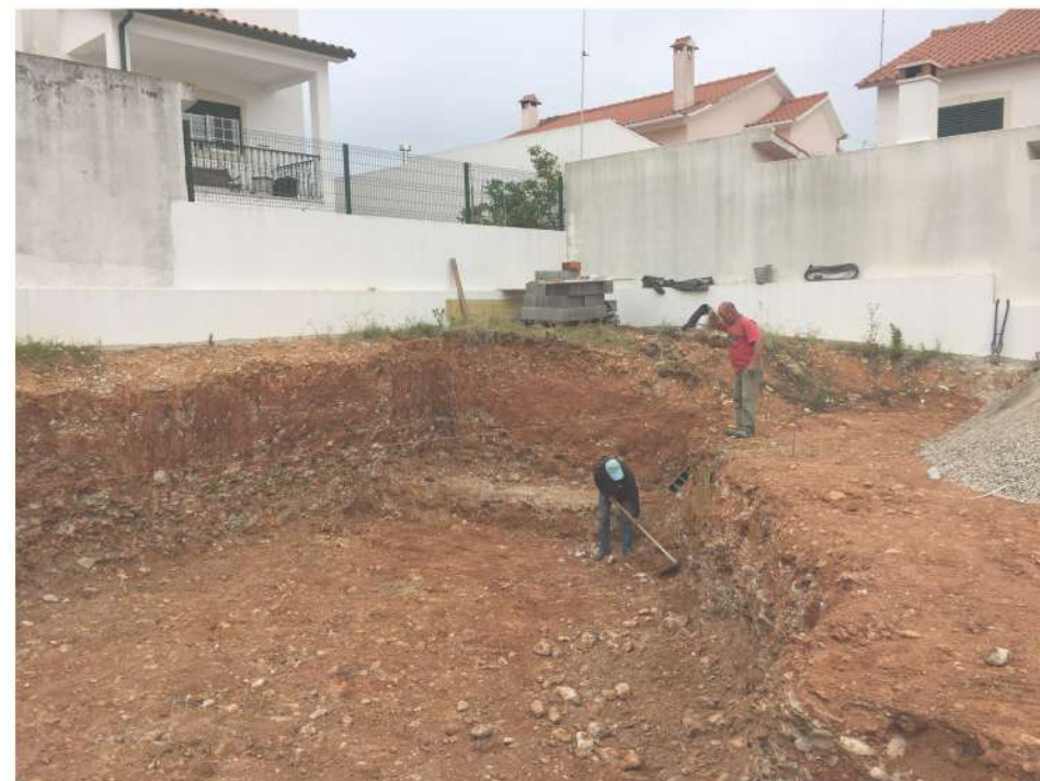
ANTES da intervenção
